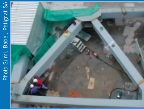
Juillet 2001 - Assemblage au sol de la charpente métallique.
