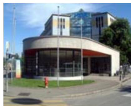
L'ancienne station-service est devenue un pavillon d'information pour le HCR.
