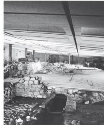
La dalle du plafond soutenant la rue fut un challenge pour les ingénieurs !
