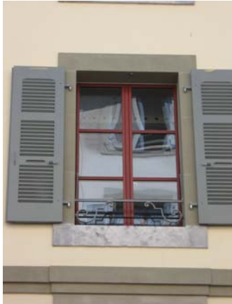
ancienne fenêtre avec vitrage isolant
