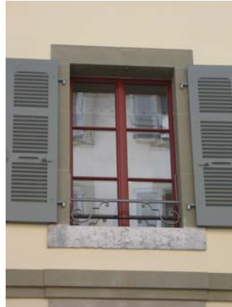
nouvelle fenêtre avec vitrage isolant.
