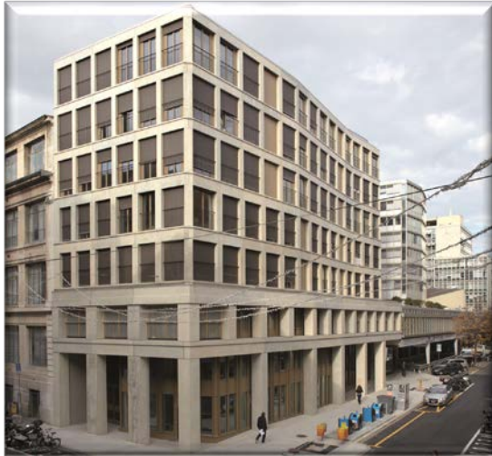
Construction de nouveaux logements et équipements publics 4-6, rue Rousseau - 7, rue du Cendrier
