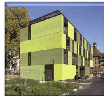
Construction d'un espace de quartier 7, avenue Blanc, Foyer de Sécheron
