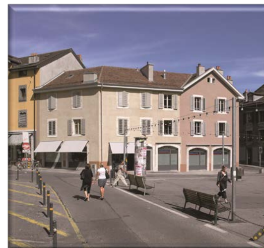
Rénovation de logements Immeuble rue des Grottes 12-14
