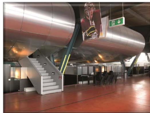
Patinoire des Vernets - rénovation centre sportif
