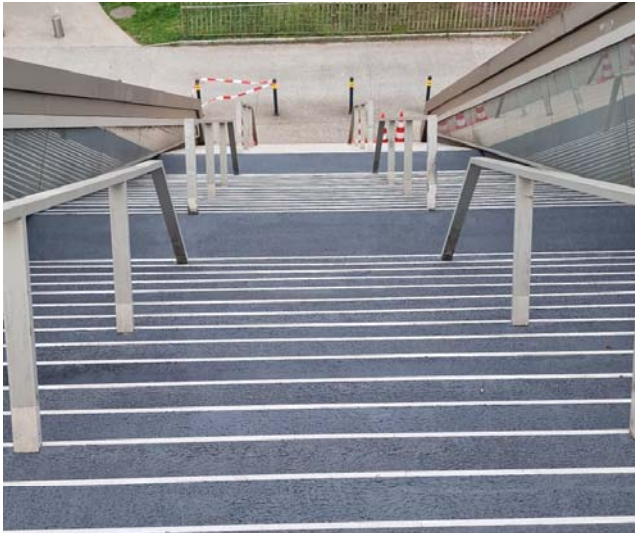
Escaliers rénovés (mars 2026)
