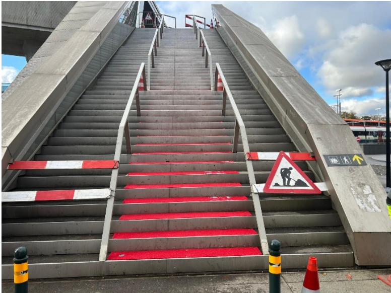
Escaliers en travaux
